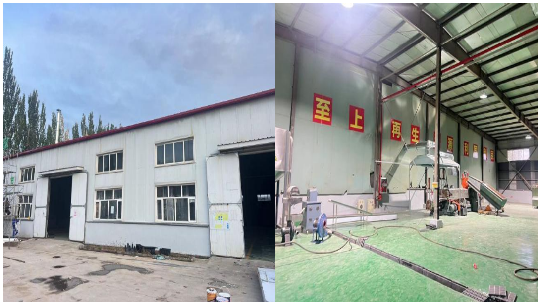
图 3-1 封闭厂房+地面防渗
